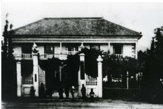
1876(明治9)年5月16日 鉦町(現中央一丁目)に県病院完成 同年5月29日より開院
